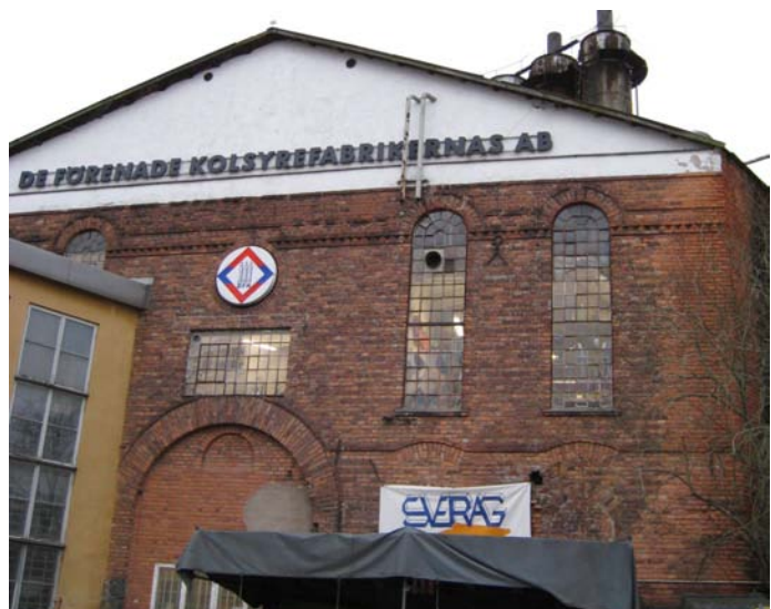
Kolsyrefabriken från nordväst (sjösidan). Bilden visar fabriken gavelparti, de sex tornen utmed långsidan samt del av pannrum.
