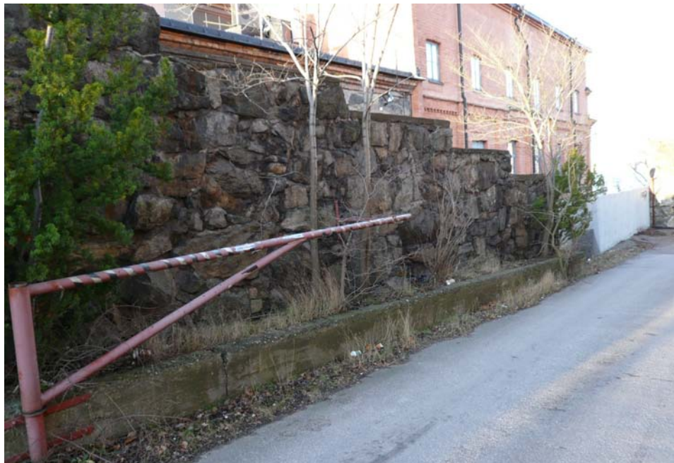
Fastighetens västra begränsningsmur sedd mot nordväst. Lägg märke till den gjutna stödmuren för planteringarna framför.
