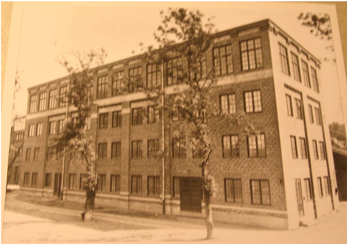
Förbandsfabriken, fasad mot vattnet i norr, 1916. På bilden kan man se byggnadens ursprungliga stora fönsterpartier med spröjsade fönster och portar i trä. Fasaden har ett tydligt repetitivt formspråk helt i linje med Industribyråns rationella arkitektur. Källa: Alcro-Beckers arkiv.
