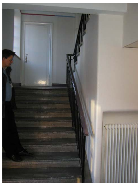
Bilder på förbandsfabriken: överst fasad mot söder med det utskjutande trapphuset, i mitten ett bevarat originalfönster med spröjs på fasaden mot norr. Bilderna nederst visar trapphuset med kalkstenstrappa, smidesräcke och originalfönster med mässingsbeslag.
