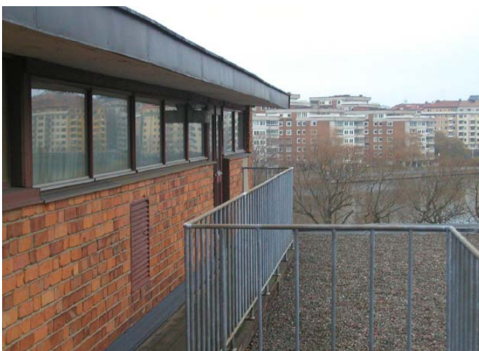
Bilden visar Nitrolackfabrikens indragna takvåning och byggnadens plåtklädda tak som är belagt med grus.
