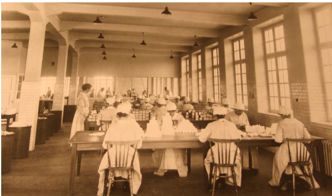
Interiörsbilder från förbandsfabriken. Samtliga bilder förutom bilden med laboratoriemiljön, är tagna på fabriken's översta våningsplan, arbetssalen, år 1916. Notera väggar och pelare klädda med beklädnadstegel och det stora dagljusinsläppet. Källa: Alcro-Beckers arkiv.
